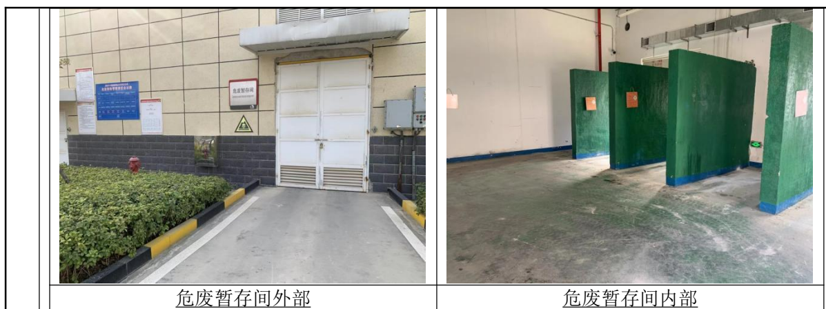
图 4-1 危废暂存间现状照片
