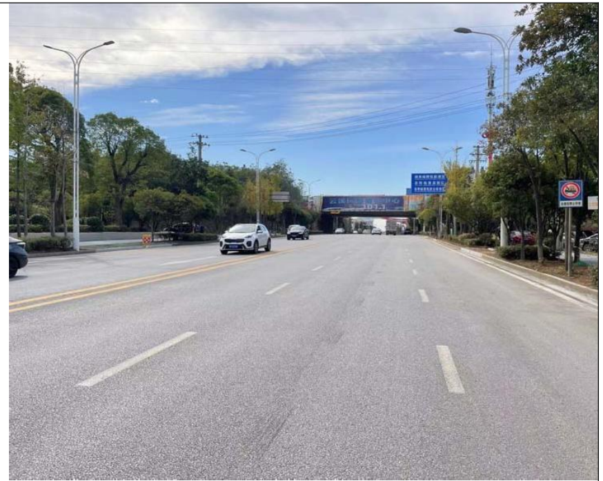
顶管穿越云港大道现状图
