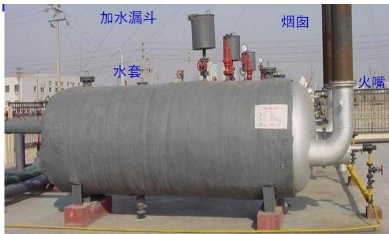
图 4-2 水套炉结构
