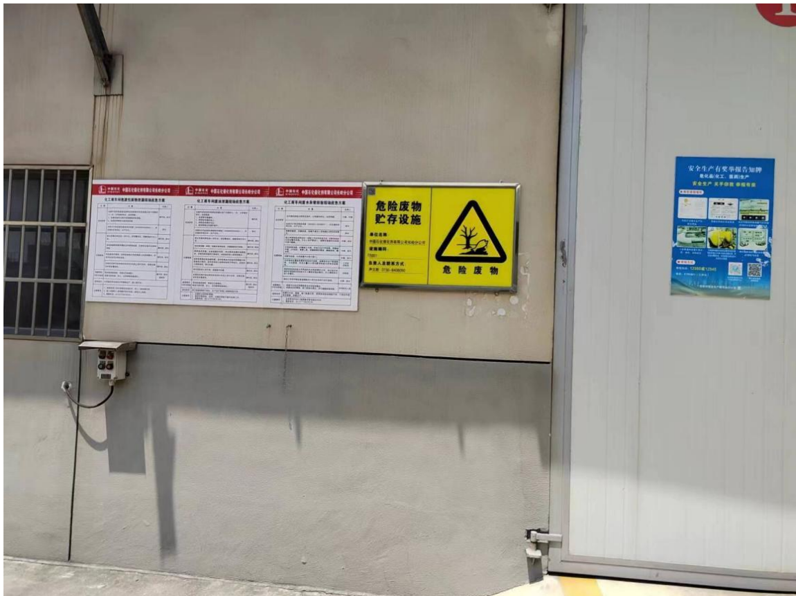
企业危废暂存间外部（依托现有）
