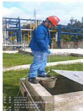
厂区污水排放口 W1 (09.30)
